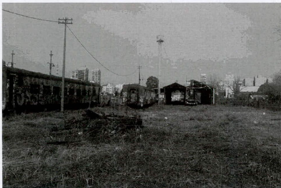
Ilustración 38: Parrilla de vías enterradas, vagones destruidos
