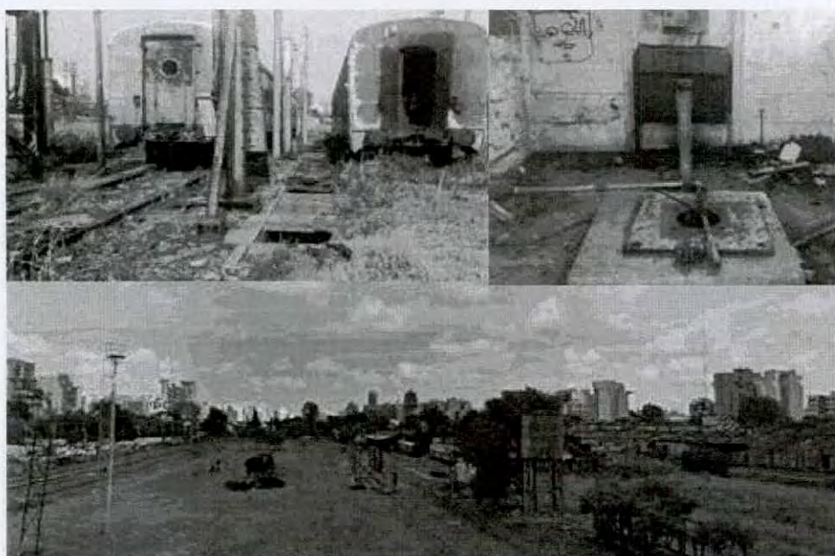
Ilustración 40: Vista desde el puente de las instalaciones del lavadero, mantenimiento, tanque de agua y casilla de pozo. Arriba pozo de agua y lavadero de vagones
