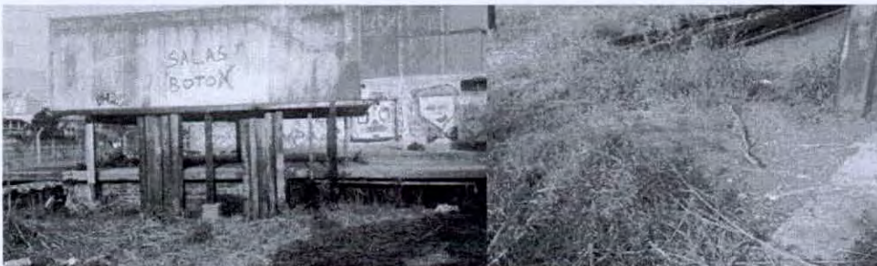
Ilustración 37: Tanque para lubricante (izquierda) y manchas de Hc secas en suelo (derecha)
