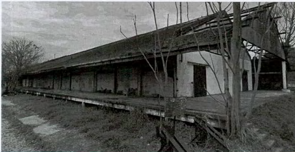
Ilustración 35: Talleres, depósito, etc.
