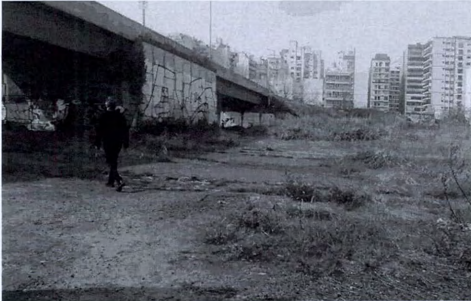
Ilustración 24: Parrillas de vías bajo Puente Caballito
